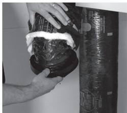
Insérer un conduit en vinyle sur les crochets et sceller avec un Tie Wrap.
